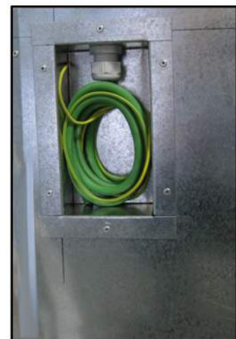
foto 2: caja de conexiones y prensaestopa.
