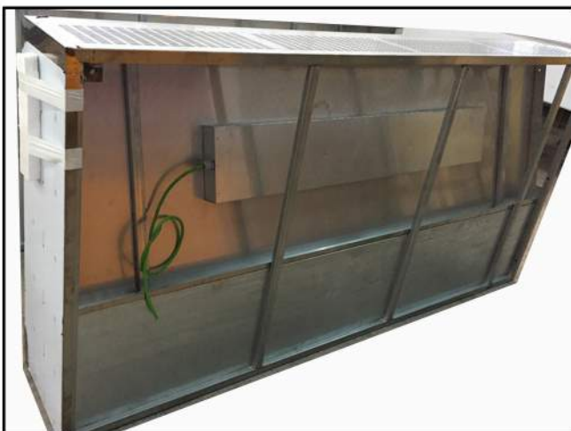
foto 1: holgura de cable eléctrico entre luminaria y caja de conexiones.
